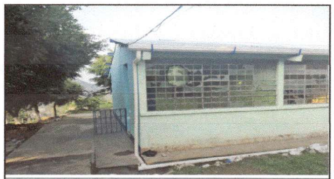
Foto 6: Dirección Instalación canal y tubo caída pluvial
