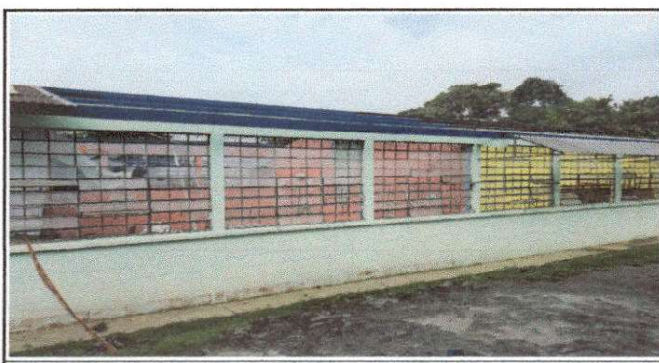
Foto 5: Atrás pintura de estructura
